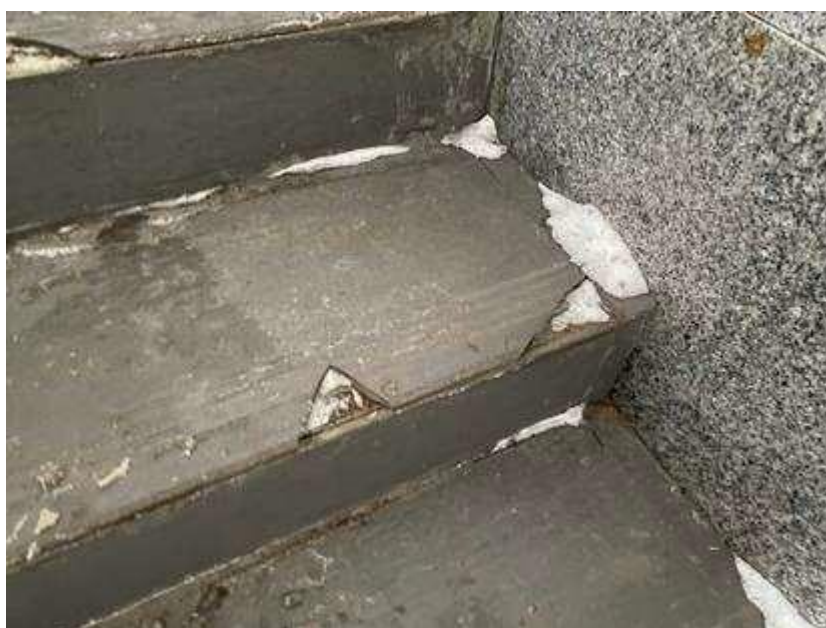
Фото 26. Разрушение плитки
