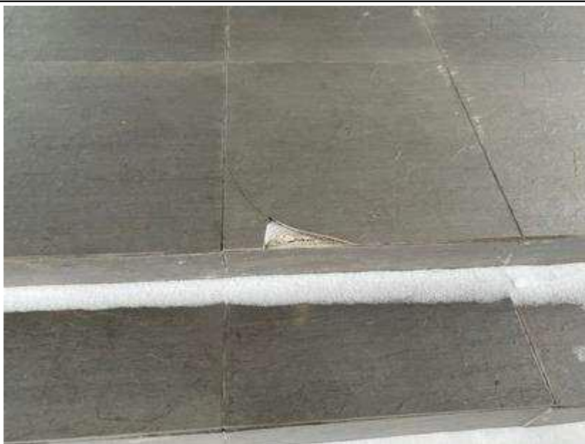
Фото 17. Разрушение плитки
