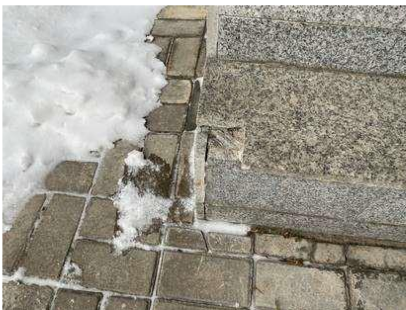
Фото 24. Разрушение плитки
