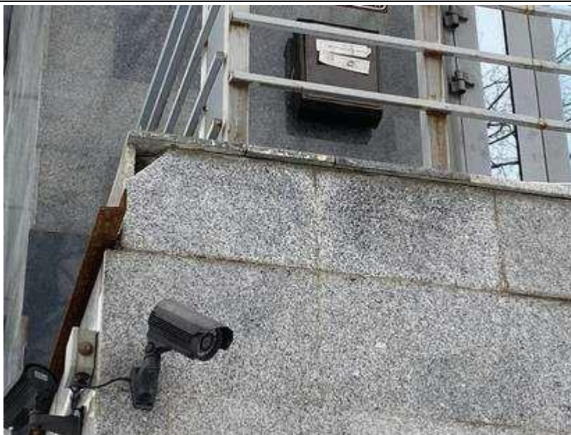
Фото 51. Разрушение плитки
