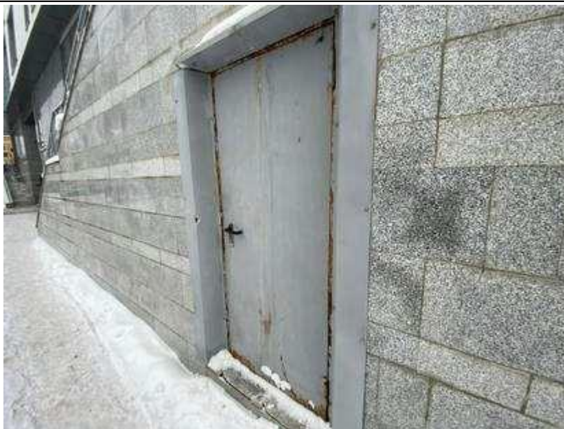
Фото 45. Коррозия металла
