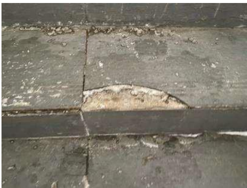
Фото 16. Разрушение плитки
