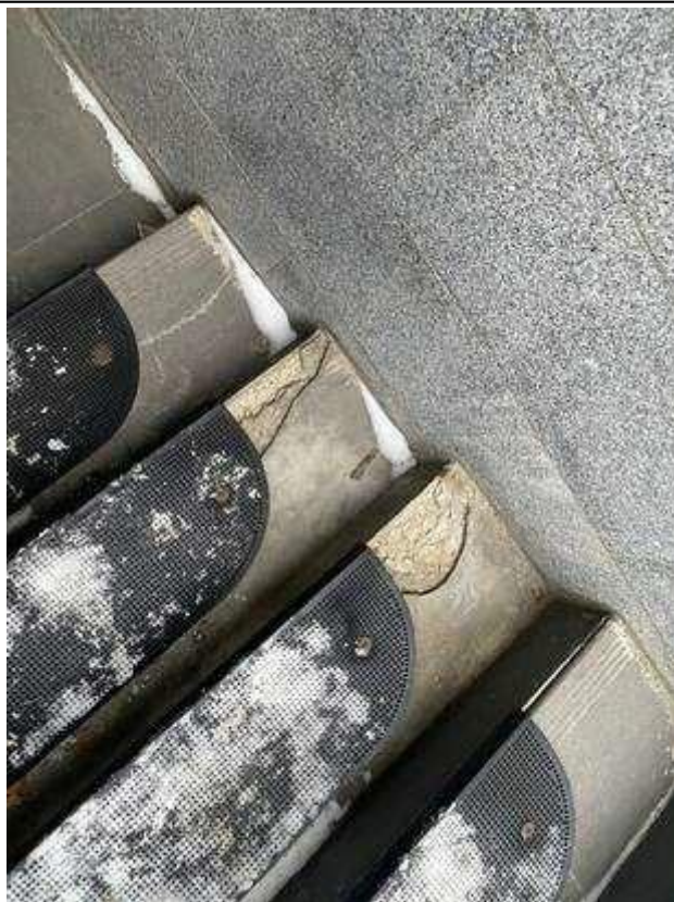
Фото 9. Разрушение плитки
