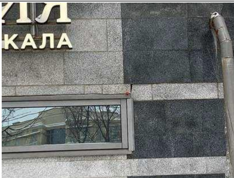
Фото 31. Разрушение плитки
