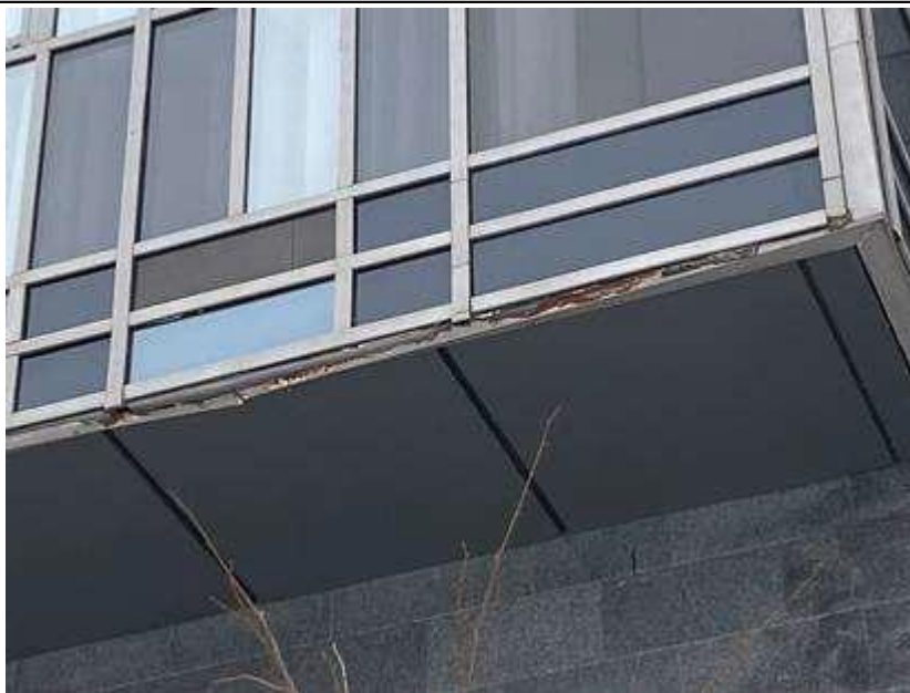
Фото 29. Коррозия металла
