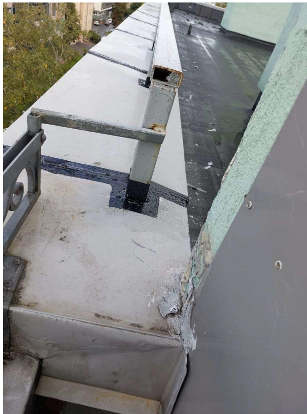
Фото 42. Деформация оцинкованных открытых парапетов.
