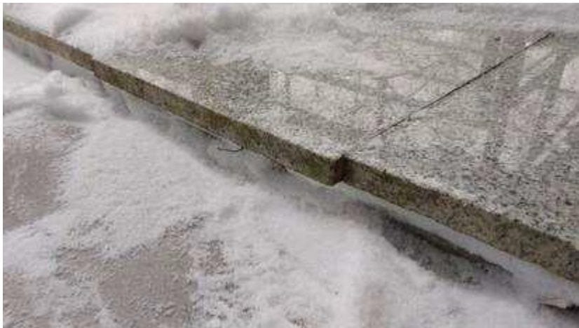
Фото 28. Негерметичное соединение окрытий парапетов.
