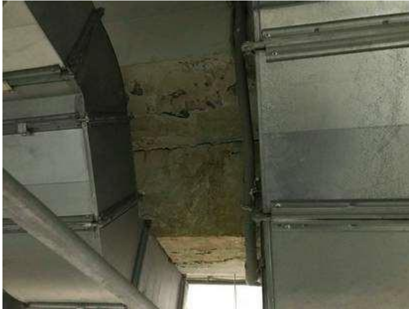
Фото 37. Протечки кровли местами
